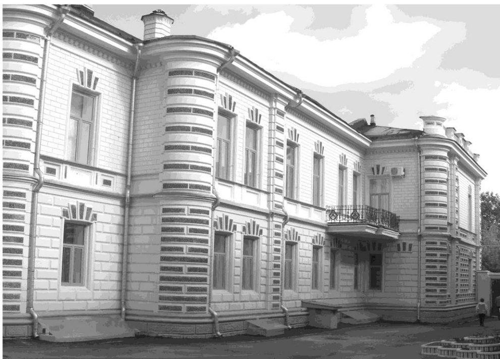
Рис. 65. Вид особняка с ул. Ильинской (вверху) и со двора (внизу) после реставрации
