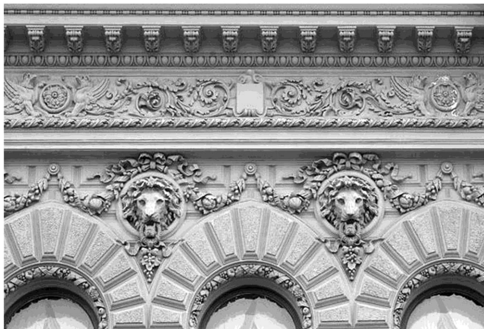
Рис. 3. Особняк П.П. фон Дервиз в Петербурге. Общий вид (вверху), фрагмент стены с орнаментами и масками львов (внизу). Фото.
