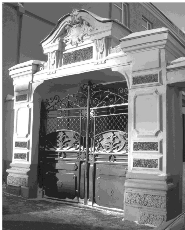
Рис. 66. Вид дворового фасада (вверху) и проездных ворот (внизу) после реставрации.
